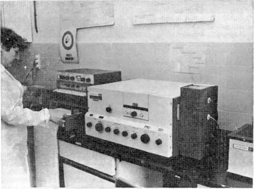
5. ábra: Perkin-Elmer spektrofluoriméter fluoreszcencia szinképek felvételére
